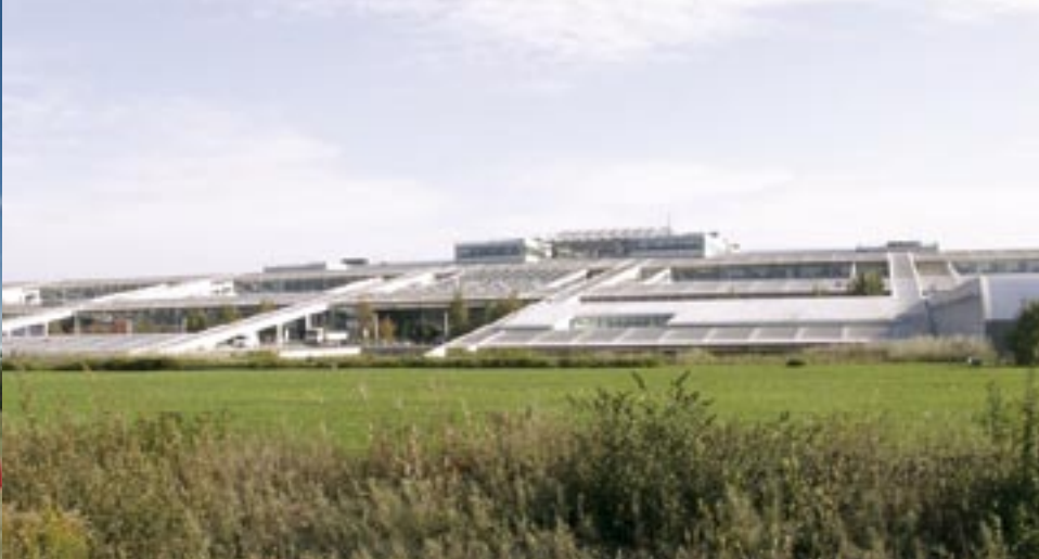
Sur un terrain de 150 ha, le Technocentre Renault est conçu (dès 1991) sur des plans d'ensemble des architectes Valode et Pistre. Au total, ce sont 600 000 m 2 de bureaux, laboratoires, espaces de détente...
