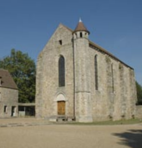
La chapelle de la Commanderie des Templiers de la Villedieu, à Elancourt, datée du XIII e siècle, est classée au titre des Monuments historiques en 1926.
